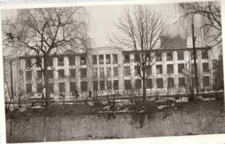
Budynnek fabryczny po nadbudowie lewego skrzydła.
